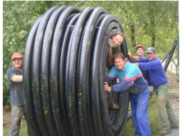
Verlegen der Fernwärmeleitung
