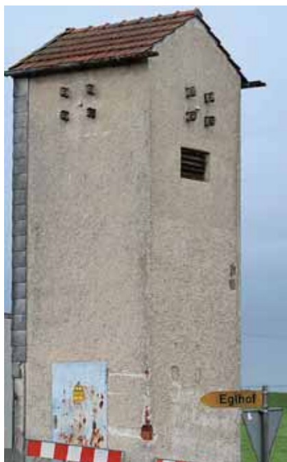
So sahen die Trafostationen früherer Jahre aus.
