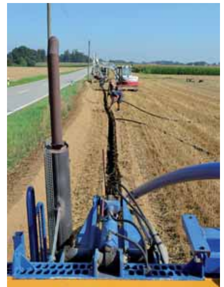
Der Ausbau des Trinkwasser-Netzes im westlichen Gemeindebereich ist (fast) abgeschlossen.
