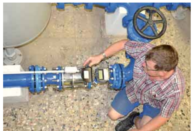
An den neu eingebauten Digitalzählern können die Wasserverbräuche effektiver kontrolliert werden.
