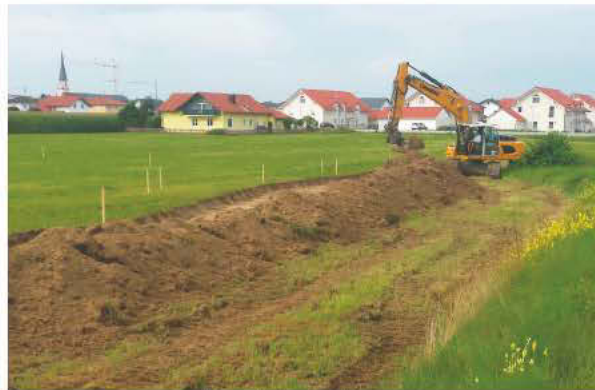
Ende August rückte der erste Bagger im neuen Wohngebiet „An der Altöttingerstraße“ an.
