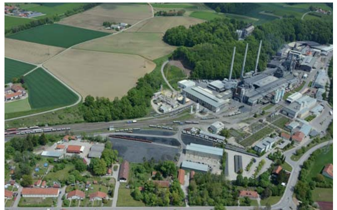
Ortsteil Werk Hart Unterneukirchen
