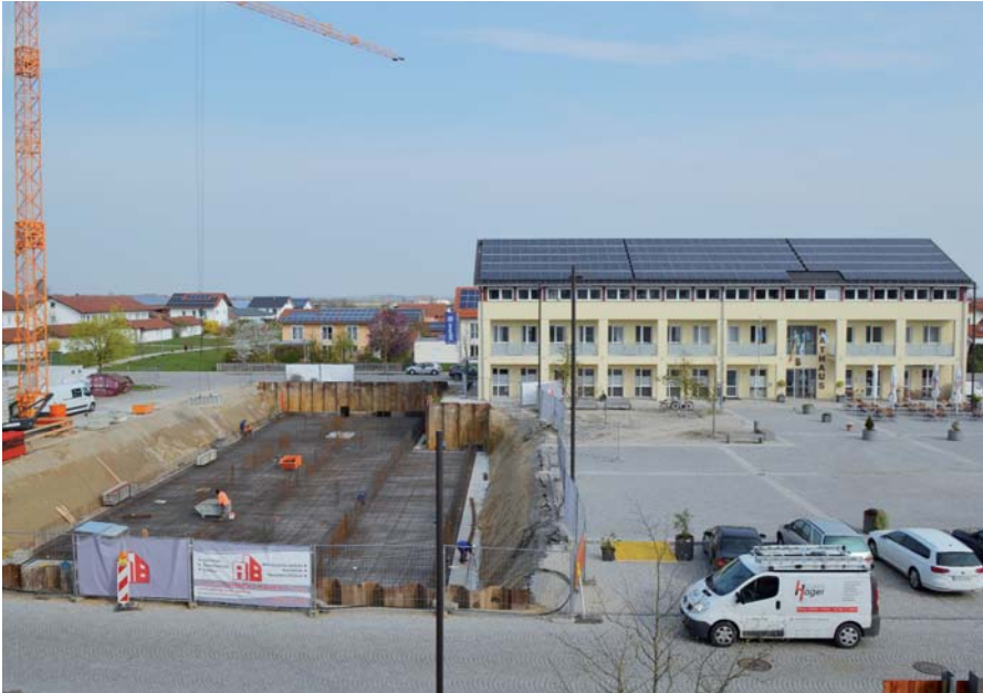
Das Frühjahr über bildete die tiefe Baugrube in der Ortsmitte den Blickfang im Dorf.
