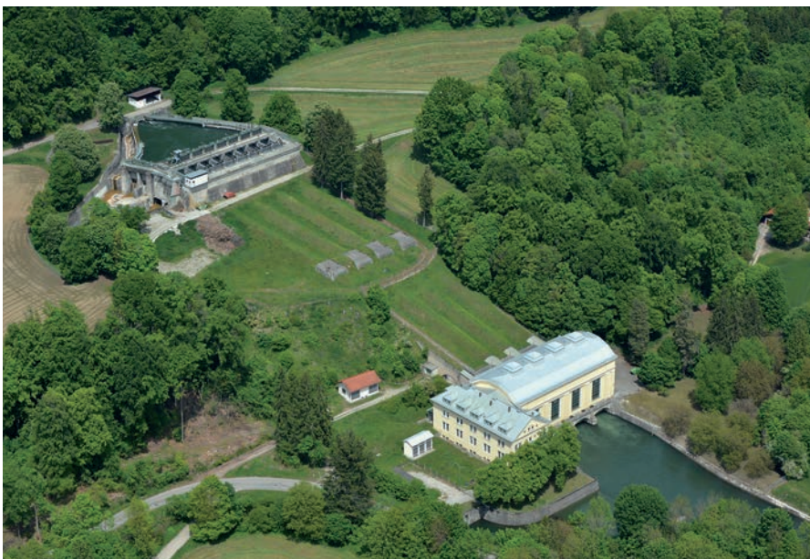
Am Ende des Kanals stürzt das Wasser aus dem Becken oben in vier Rohren mit je drei Meter Durchmesser 37 Meter in die Tiefe und treibt die Turbinen im Kraftwerk an.
