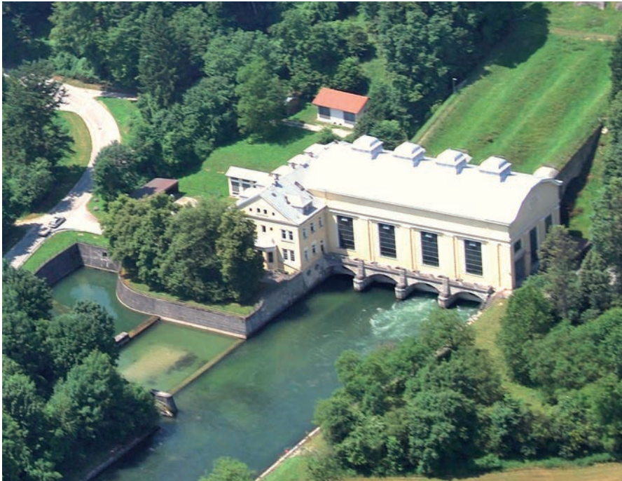
Wegen seines klassizistischen, schlossähnlichen Baustils wird das im Unterneukirchner Ortsteil Mühlthal stehende Kraftwerk im Volksmund auch "Wasserschloss" genannt.
