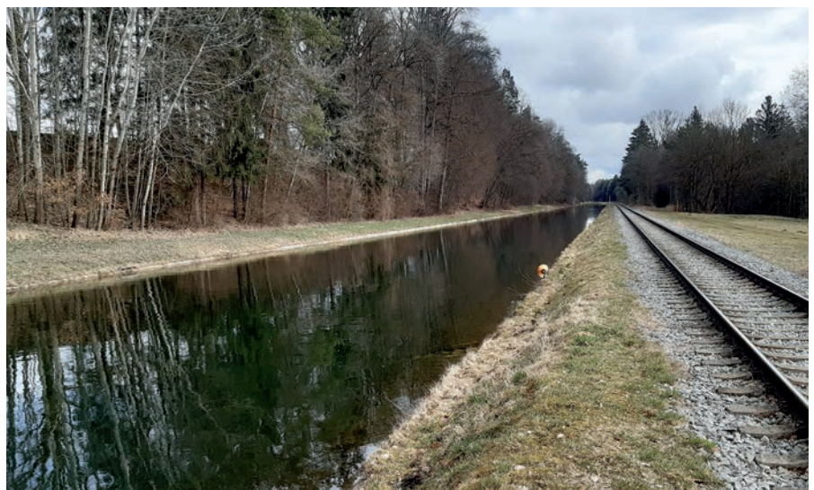
Ab Garching verlaufen Alzkanal und Bahnlinie parallel nebeneinander
