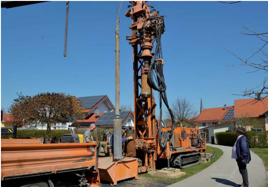
Eine seiner letzten Amtshandlungen: Georg Heindl beobachtet den Beginn der Bohrarbeiten für die drei geforderten Grundwasser-Messstellen. Text/Foto: S. Gruber
