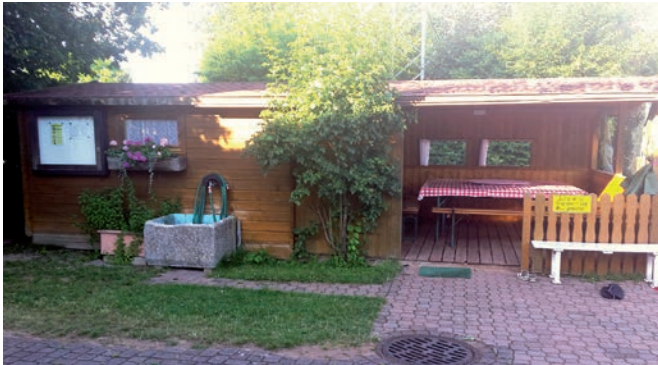
1990 wurde der linke Teil des alten Tennishäusl erstellt und einige Jahre später erst erfolgte die Überdachung des Freisitzes.
