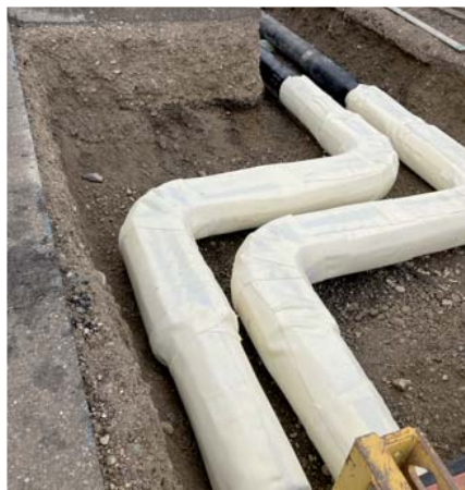
Fernwärmeleitung bei einem Projekt der EGIS eG (Quelle: EGIS eG)
