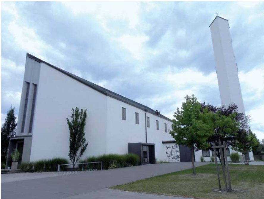
Der barrierefrei gestaltete Kirchenvorplatz
